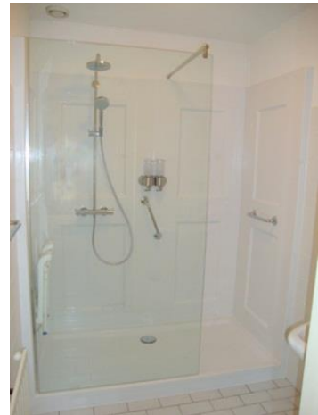
Ihr neues Bad mit der Dusche
