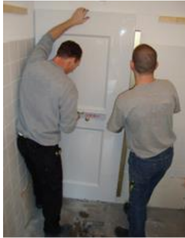
Demontage Badewanne, Montage der Duschelemente
