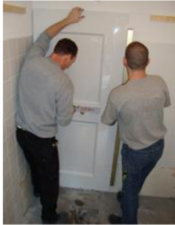
Demontage Badewanne, Montage der Duschelemente
